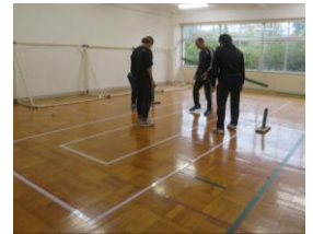
補修したコート
